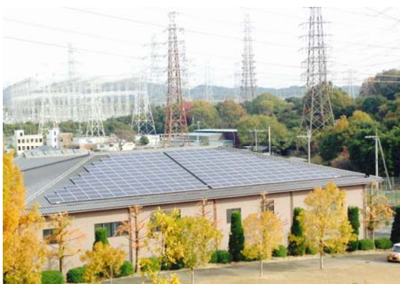
生駒市エコパーク21に設置した1号機
