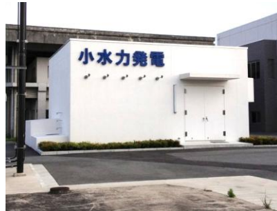
山崎浄水場に小水力発電機を設置。電力買取制度 (FIT) による売電を実施。平成 25 年 3 月稼働。設備容量 40kW。年間発電見込み 35 万 kWh。
